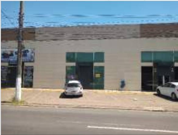
F.03 : fachada L.03 Tom Jobim.
