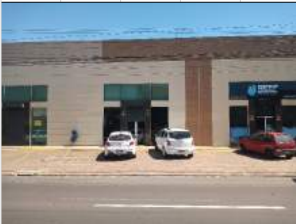
F.05 : fachada L.04 Tom Jobim.
