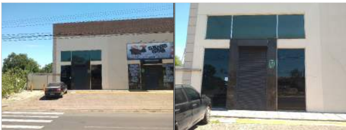
F.01 : fachada L.01 Tom Jobim.
