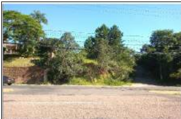
F.01 : vista pela Av. Feitoria.
