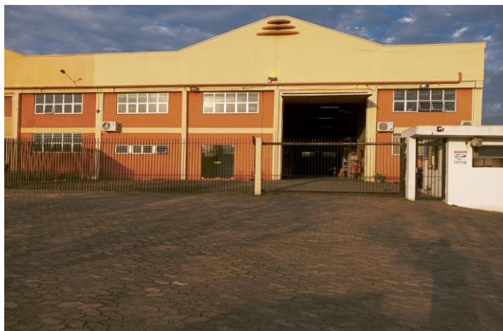
Centro de Distribuição
