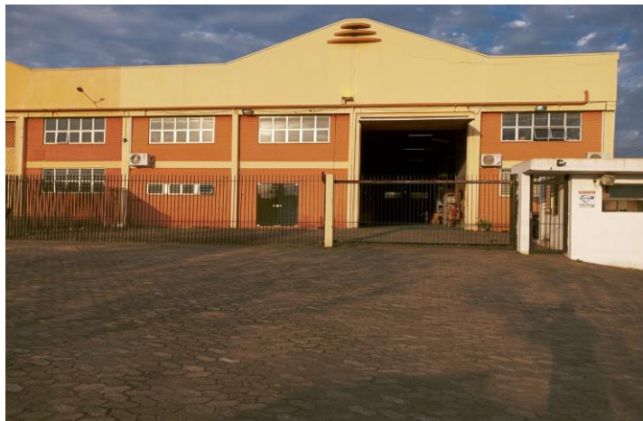
Centro de Distribuição
